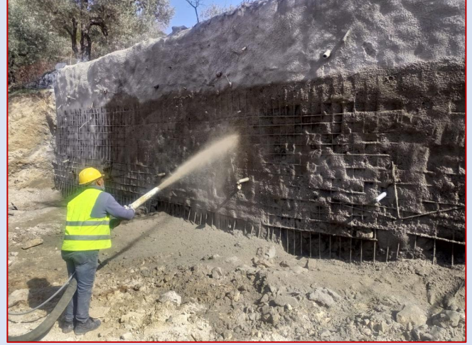
فريق CSP يصب الخرسانة أثناء إنشاء محطة بشعلة لمعالجة مياه الصرف الصحي الممولة من الوكالة الأميركية للتنمية الدولية
