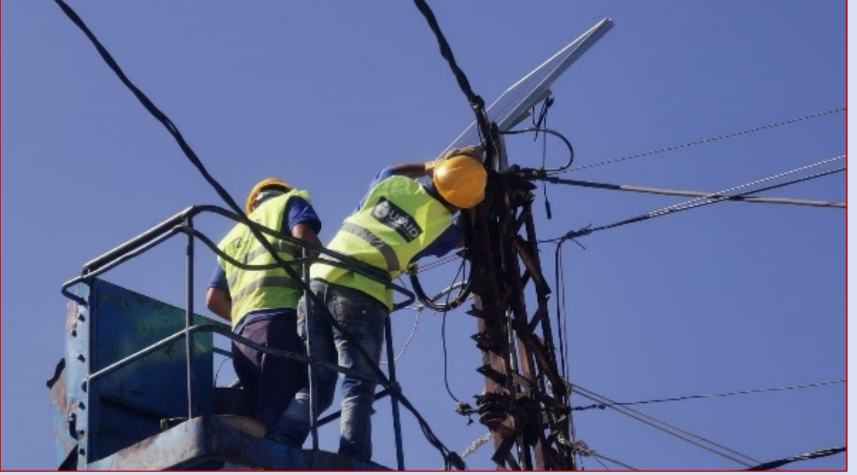
CSP يركب إنارة شوارع تعمل على الطاقة الشمسية في كفر جراً، جنوب لبنان
