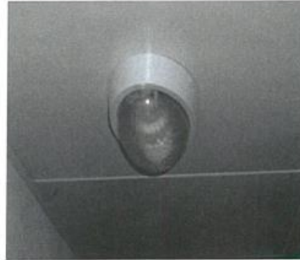
الرسم ٦- أضواء مع أغطية من البلاستيك لمنع تجمع الغبار وللحفاظة على مستوى الاتارة La Ferme St. Jacques
