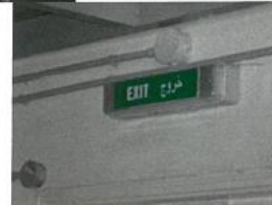
الرسم ١٣- مخرج الطوارئ مضاء بشكل صحيح Beesline
