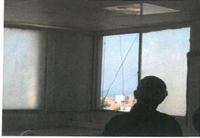
الرسم ٥- استخدام النوافذ لتوفير تهوية المتعاكسة Beesline
