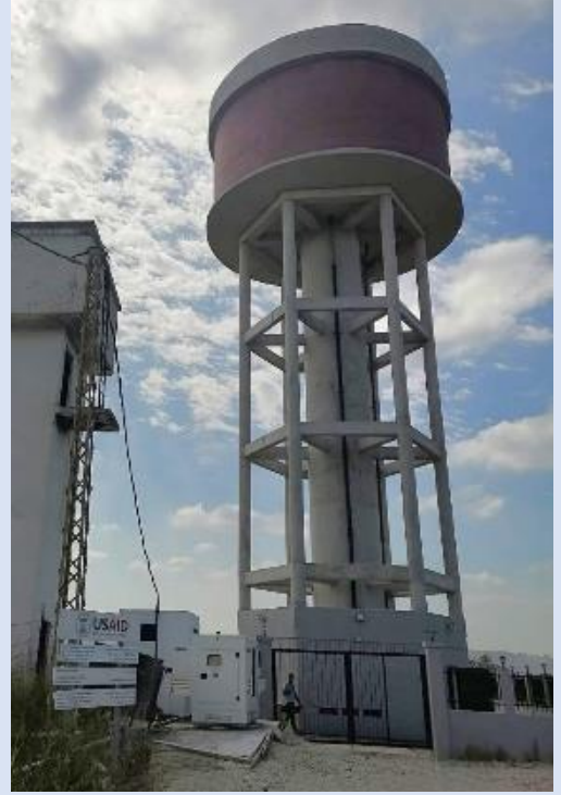
خزان المياه الذي أنشاه برنامج دعم المجتمع المحلي بارتفاع 300 متر مكعب في جنسنايا، جنوب لبنان - كانون الأول/ديسمبر 2023
